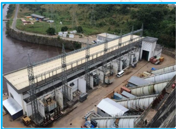
Centrale hydroélectrique de Tubi Tubidi
